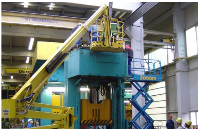
Демонтаж кузнечно-прессовой линии на заводе Franke Deutschland GmbH в городе Бад-Зэкинген (Германия)
