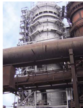
Воздухоподогреватель на Чусовском металлургическом заводе
